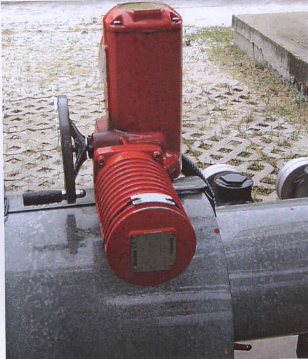
Obrázek 2 – Hlavní uzavírací armatura s elektrickým ovládním
