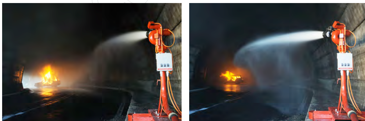
Galleria stradale Montelibretti (incendio autovettura)
